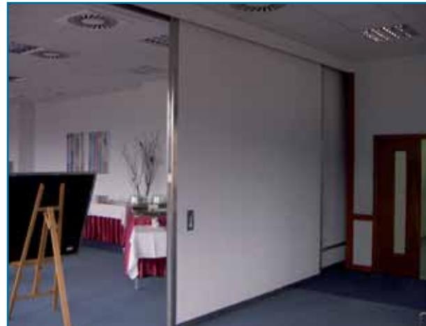
Požární posuvné uzávěry ocelové jsou zkoušeny dle evropských standardů (ČSN EN), jsou vyráběny na zakázku dle rozměrových požadavků zákazníka a lze je dodat v následujícím provedení:
